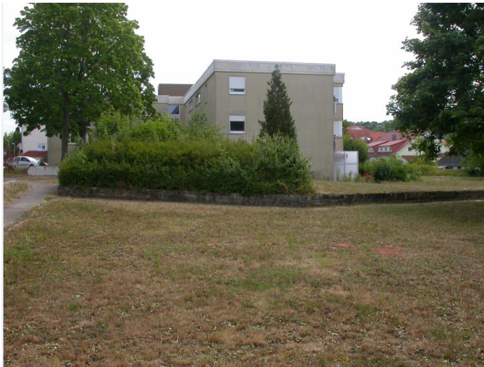
Abb. 2 Blick von Westen auf die westliche Gebäudeseite des Anwesens Bülzenstraße 1 mit dem Mäuerchen und dem Rasen im Vordergrund (Photo E. Wonnenberg v. 27.06.2014)
