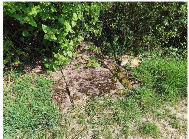
Abb. 13: Auslaufschacht der Kläranlage
