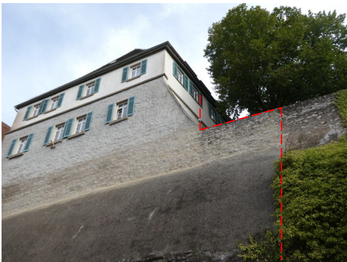
Bild 36 Westliches Ende des Sanierungsabschnitts; links: Sanierungsabschnitt aus dem Jahr 2012
