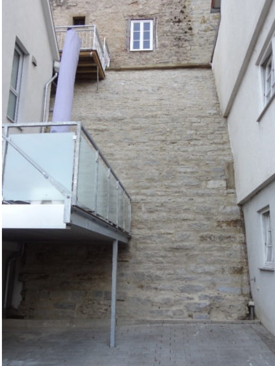
Bild 3 Sanierungsabschnitt 2020 (Aufnahme Nov. 2020)
