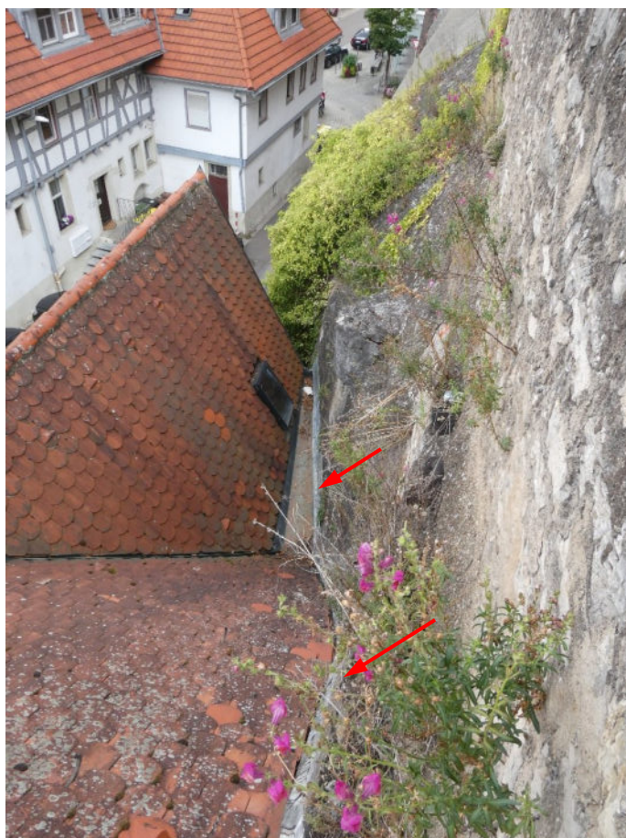
Bild 11 Mauerbereiche hinter dem Wohnhaus: Dachflächen grenzen direkt an die Stadtmauer an; die Abdichtung erfolgt über Anschlussbleche
