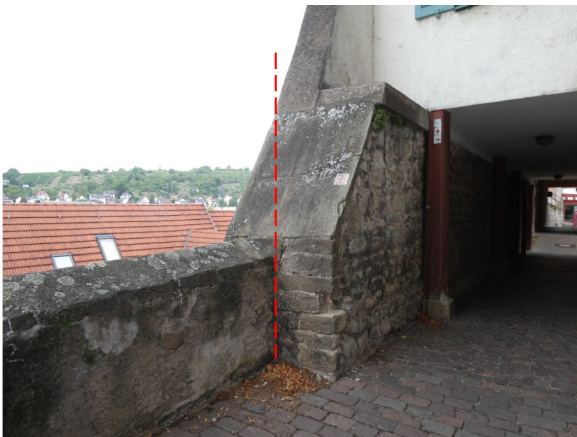
Bild 35 Westliches Ende des Sanierungsabschnitts (Anschluss an Amtsgerichtsgebäude)
