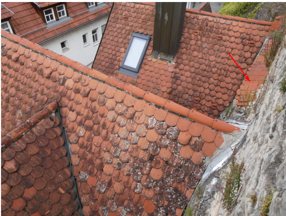
Bild 14 Mauerbereich hinter dem Wohnhaus: Mauerabsatzbereichsweise mit Biberschwanzziegeln abgedeckt
