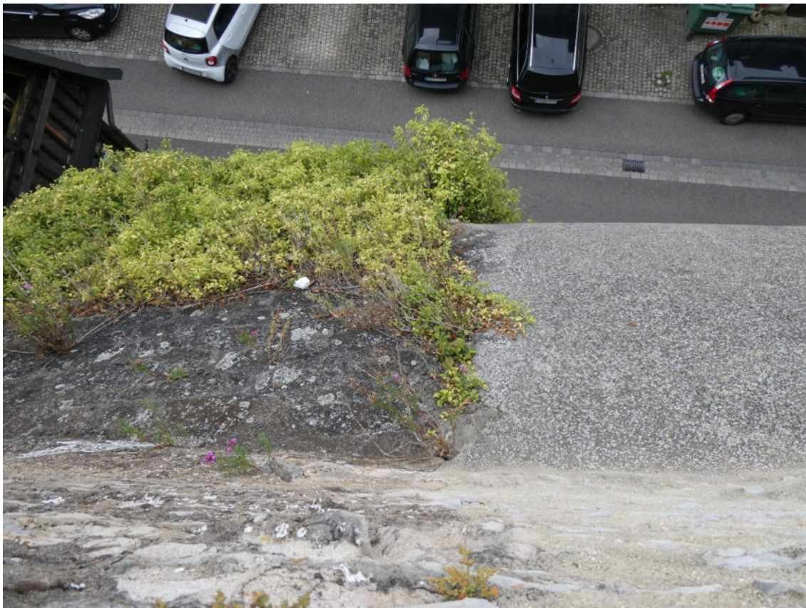
Bild 9 Bereich westlich des Wohnhauses, Ansicht von oben
