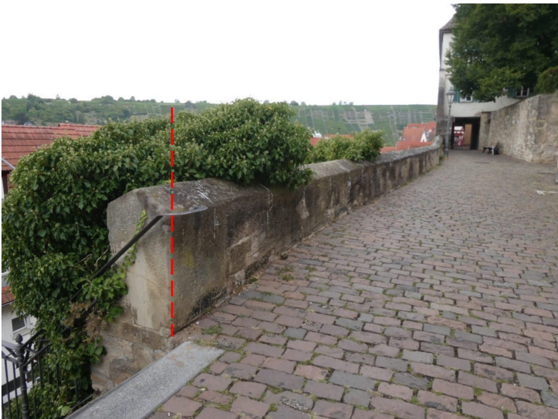
Bild 22 Brüstungsmauerwerk entlang „Auf der Mauer“; östliches Ende des Sanierungsabschnitts
