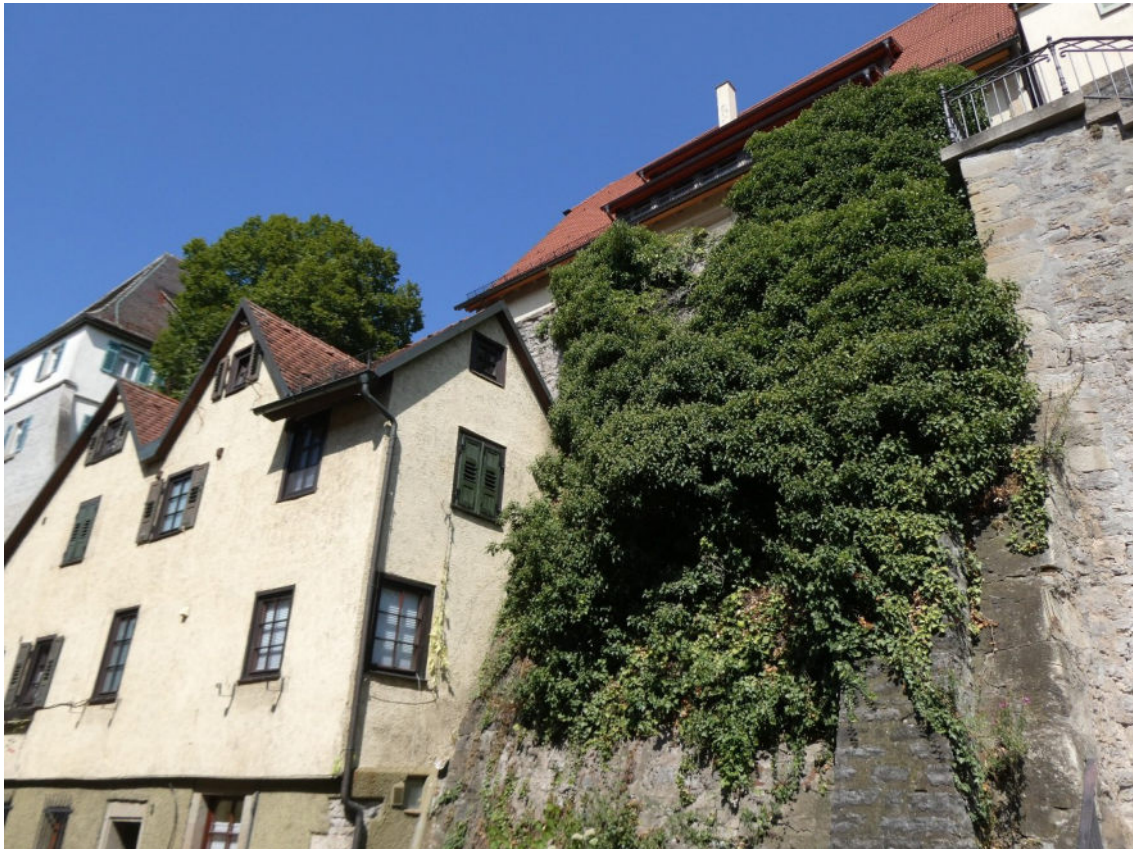
Bild 16 Bereich östlich des Wohnhauses: Mauerflächen mit dichtem Efeubewuchs überzogen
