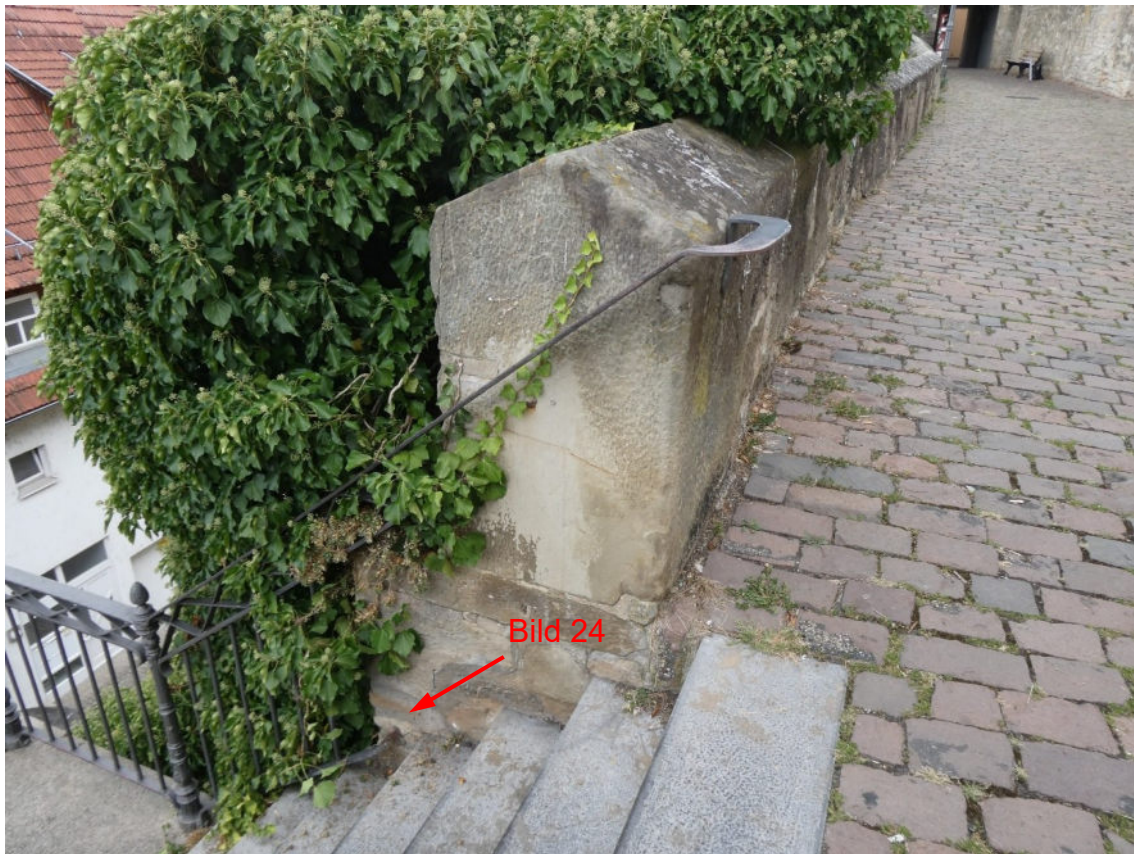
Bild 23 Östliches Ende des Sanierungsabschnitts: Ansicht des Brüstungssteins
