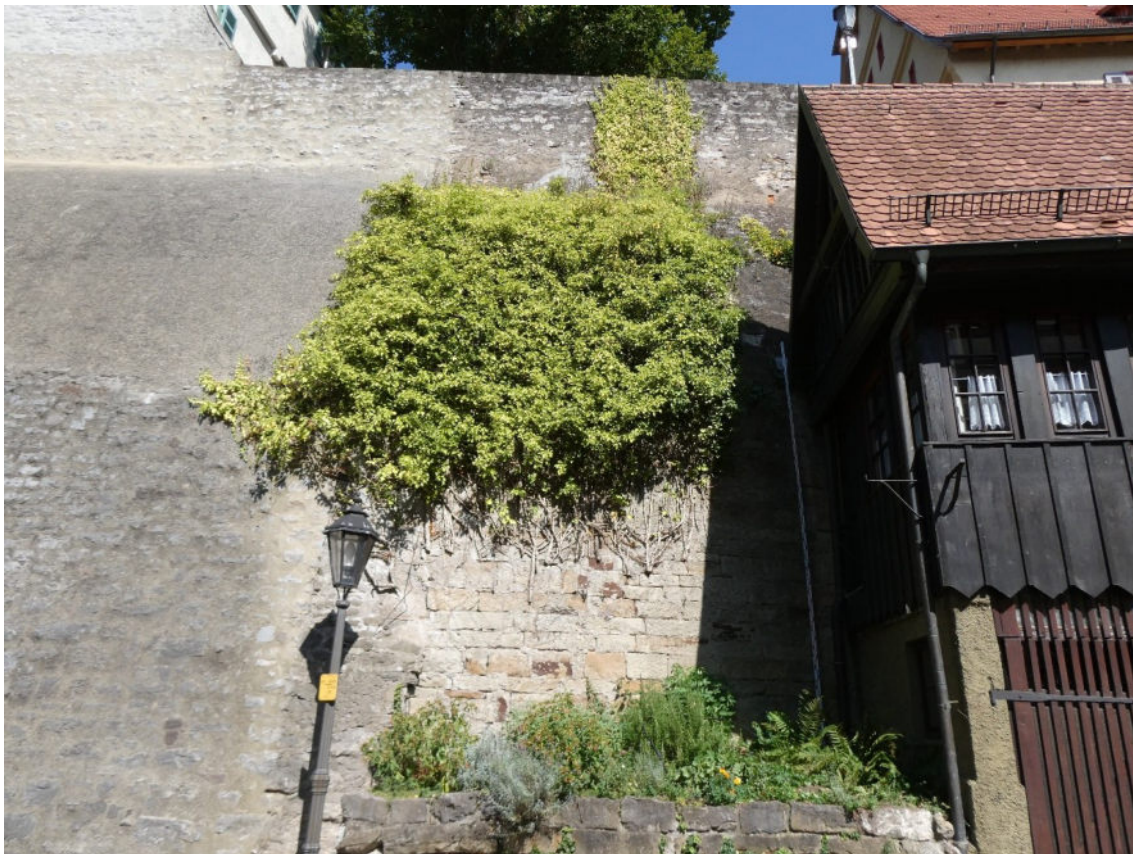
Bild 5 Bereich westlich des Wohnhauses: mittlerer Abschnitt vollständig mit Efeu überwachsen
