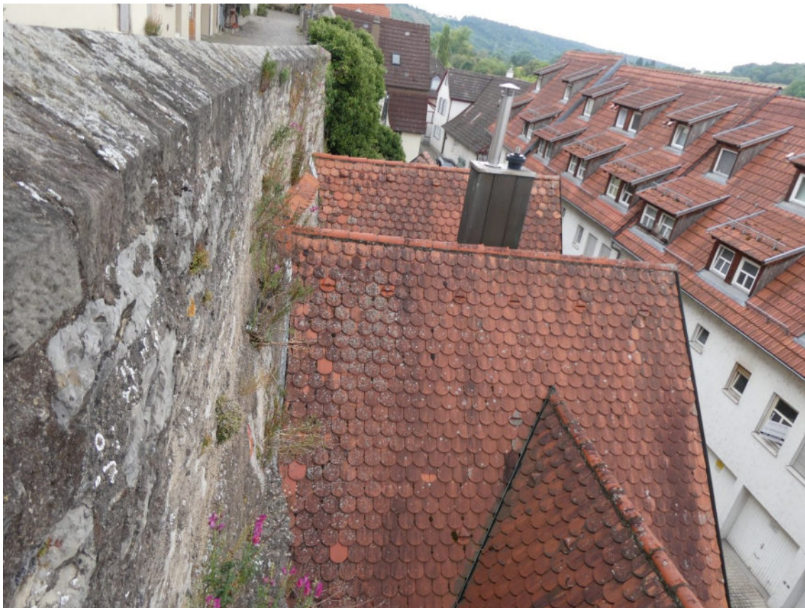
Bild 13 Mauerbereiche hinter dem Wohnhaus, Blick nach Osten entlang Brüstungsmauerwerk
