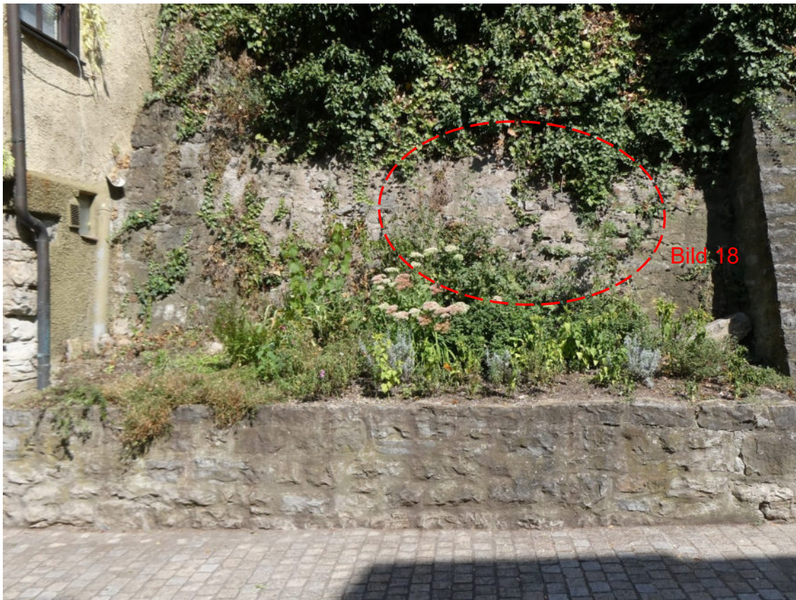
Bild 17 Detailaufnahme zu Bild 16: unterer Mauerabschnitt mit vorgelagertem Pflanzbeet und verfugter Bruchsteinmauer (nicht Bestandteil der Sanierung)
