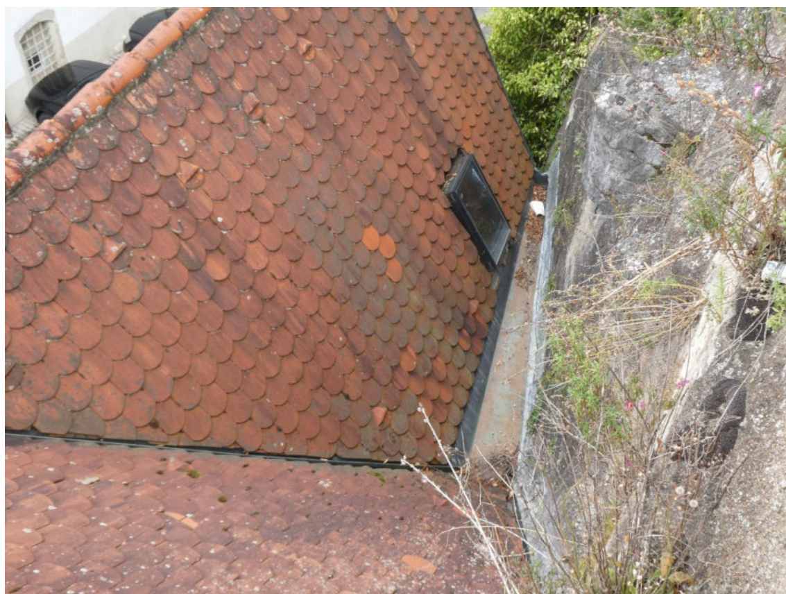
Bild 12 Mauerbereiche hinter dem Wohnhaus:
