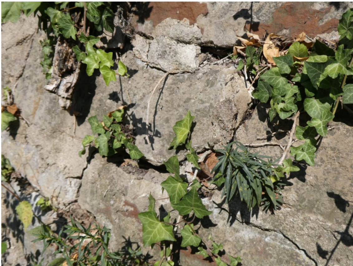
Bild 19 Detailaufnahme zu Bild 18
