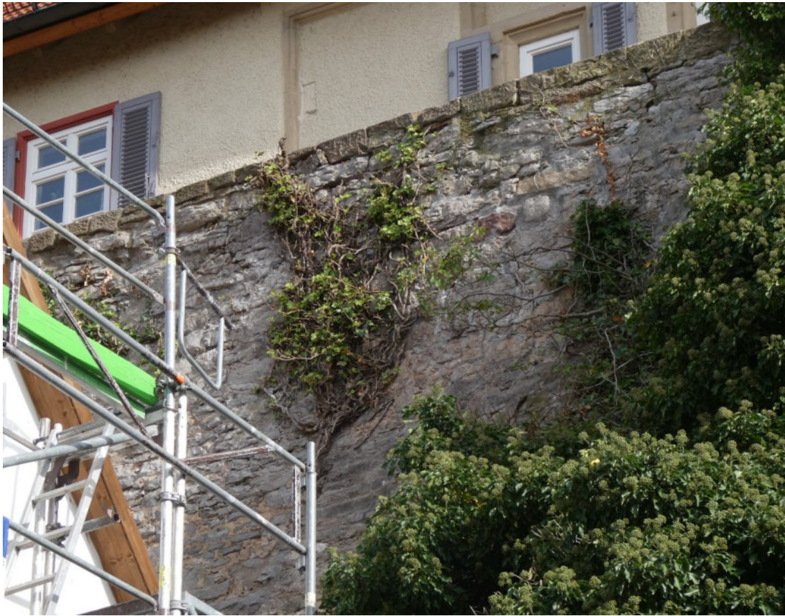
Bild 15 Mauerbereich hinter dem Wohnhaus, östlicher Abschnitt: Efeubewuchs wurde im Zuge des Gerüstaufbaus (Dach- und Fassadensanierung Wohnhaus) bereits entfernt
