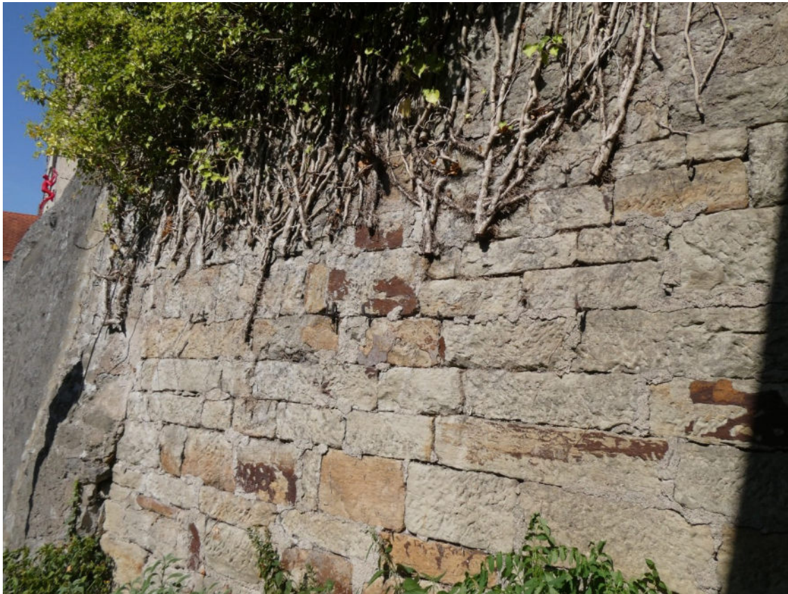
Bild 3 Detailaufnahme zu Bild 2: Sandsteinmauerwerk; Efeubewuchs im unteren Bereich bereits abgeschnitten und entfernt
