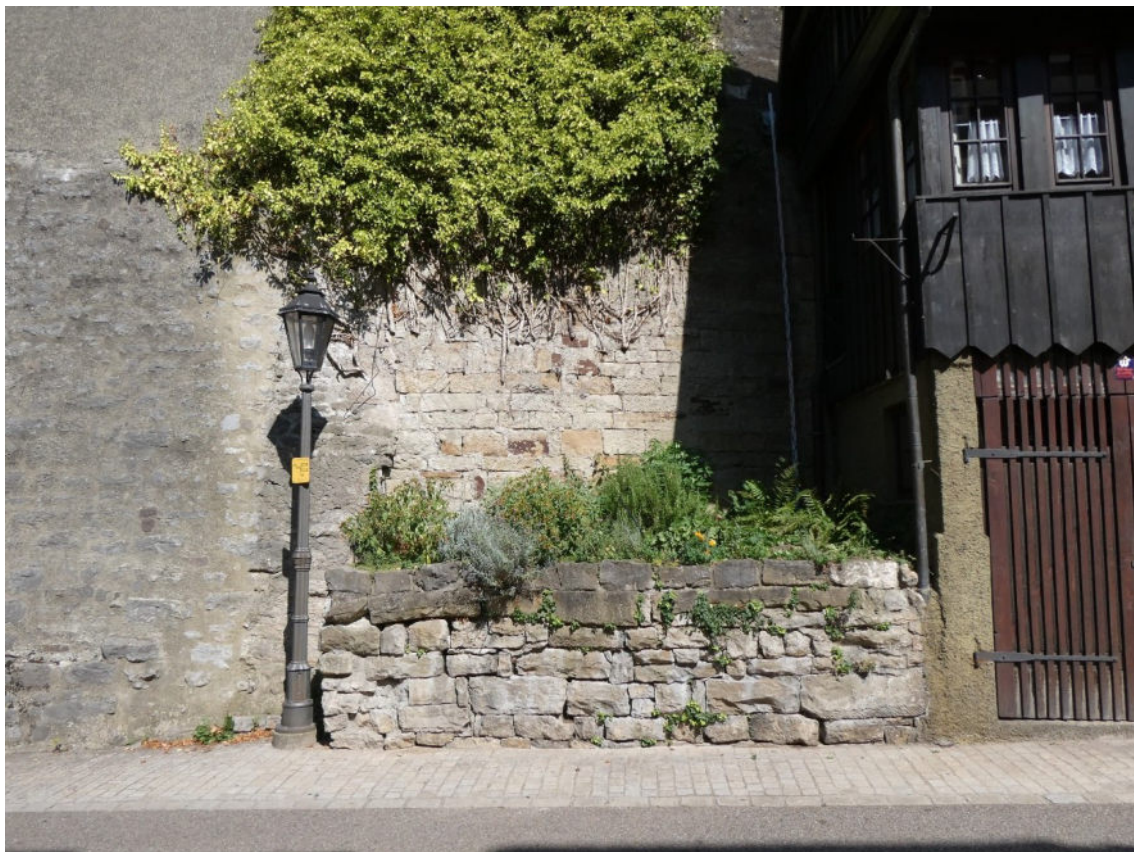
Bild 2 Bereich westlich des Wohnhauses, unterer Abschnitt: Schichtenmauerwerk aus Sandsteinen; vorgelagertes Pflanzbeet mit Bruchsteinmauer (nicht Bestandteil der Sanierung)
