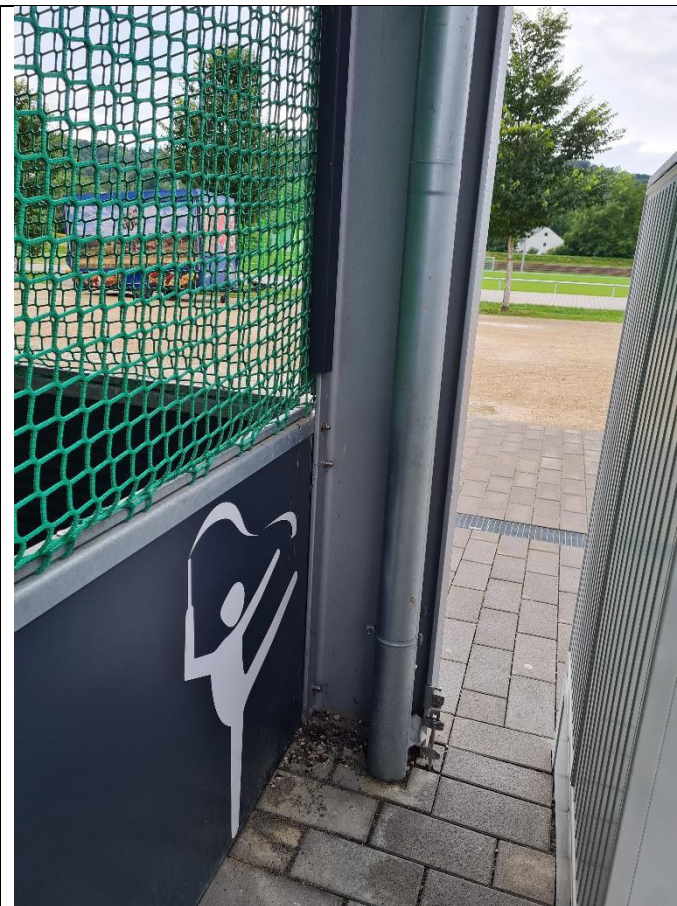
Verbindungsdetail Fa. McArena: Netzspannung durch Quadratrohrkonstruktion
