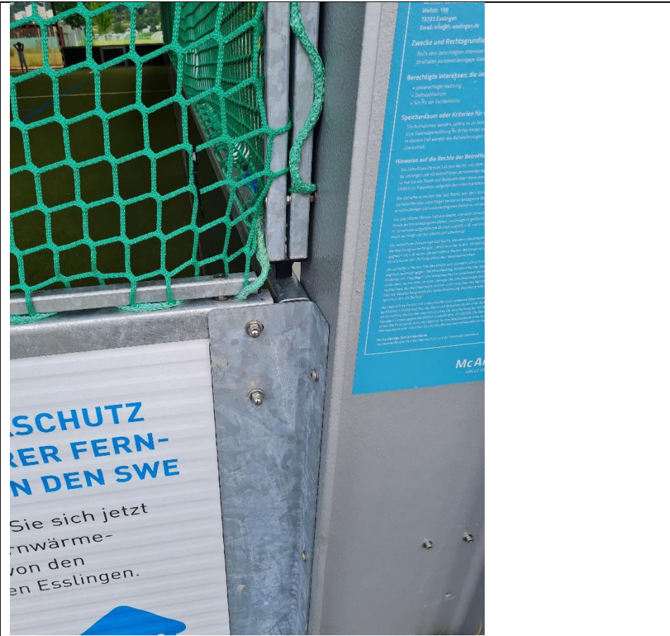
Verbindungsdetail Fa. McArena: Stahlträger – Bandensystem
