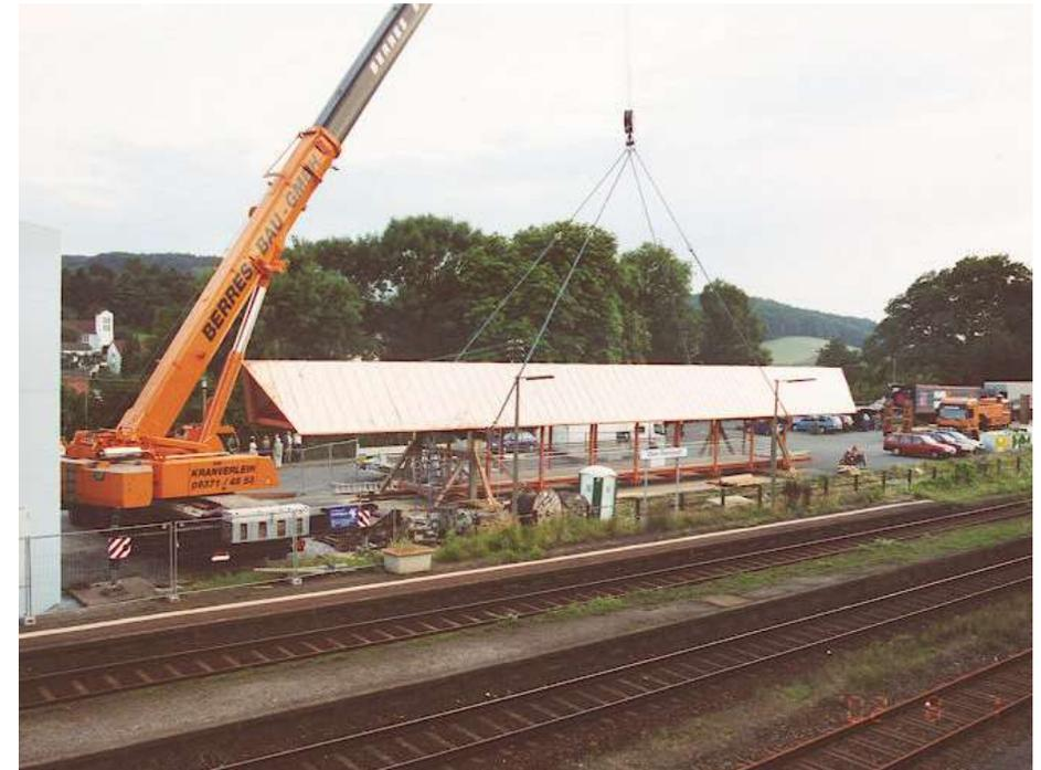
Überdachte Holz-Fußgängerbrücke über vier Bahngleise mit Aufzugsturm als Querung der DB-Gleise beim Bahnhof Ober-Ramstadt
