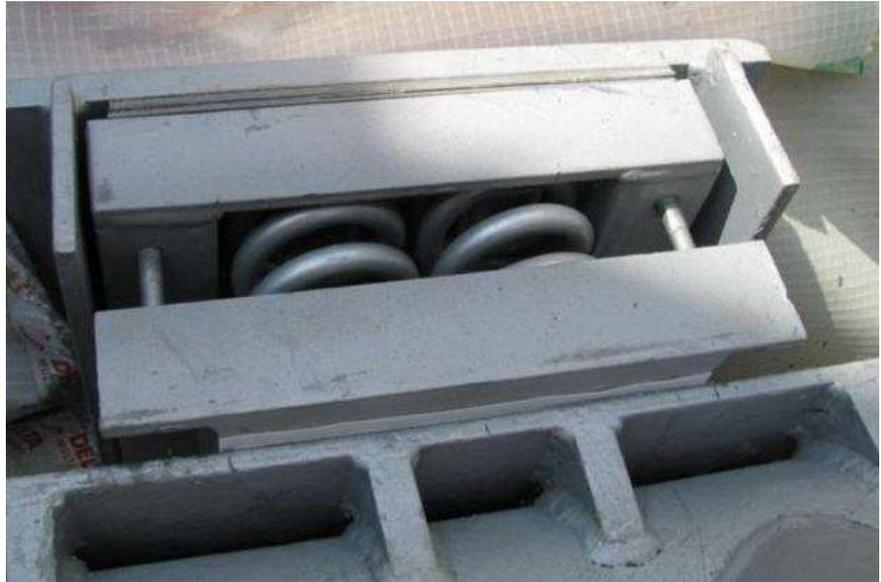
Das innovative Lagerungskonzept sowie eine günstiger Formgebung in der Kuppelbasis verringern die Summe der Lagerkräfte quer zu den Firsten auf 1/6, wodurch das Bestandsbauwerk weitestgehend von Verstärkungsmaßnahmen verschont blieb.
