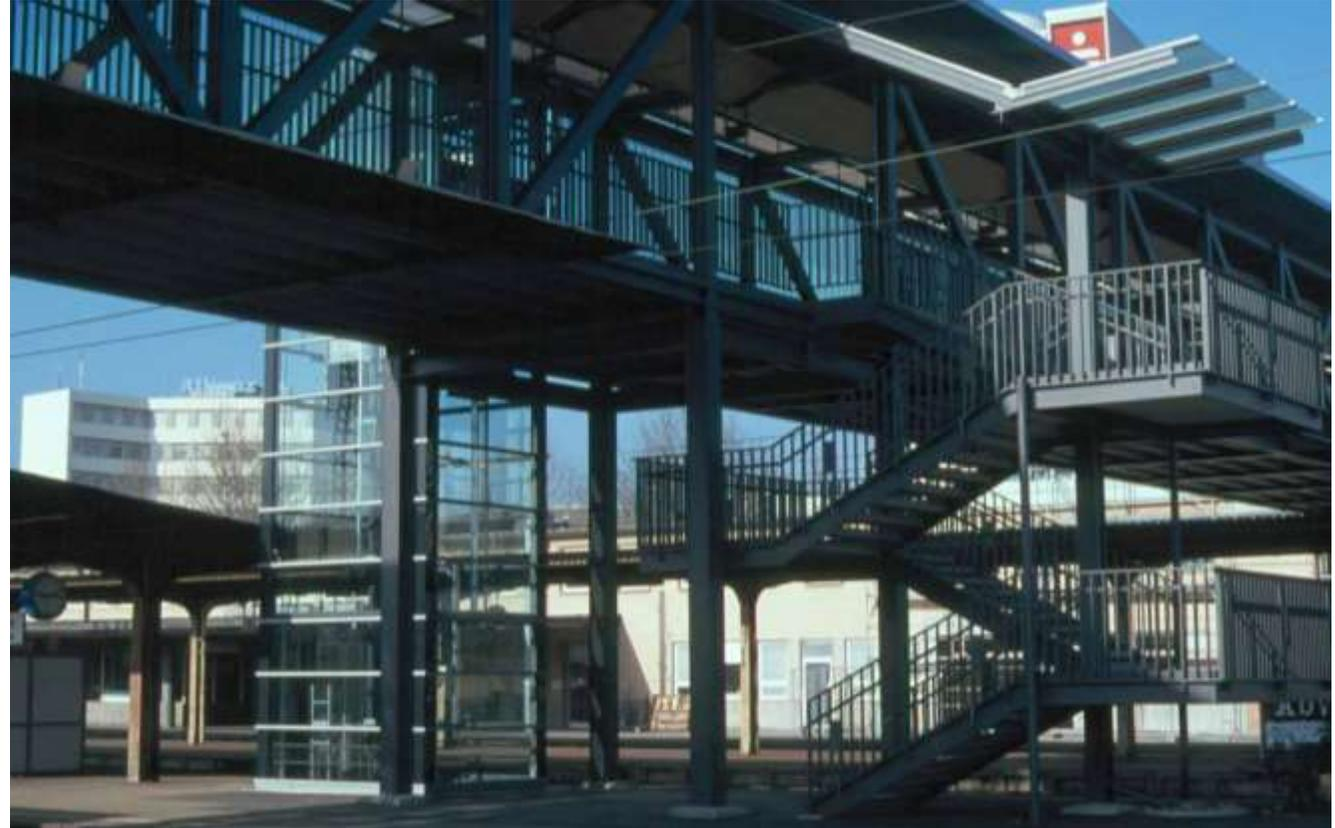
Mit der Rad- und Fußgängerbrücke zwischen der Jahnstraße und dem Bahnhof Göppingen wurde eine direkte Verbindung zwischen der Innenstadt und dem Bahnhof geschaffen. Die Konstruktion der Brücke besteht aus Stahlfachwerkträgern, die als Einfeldträger auf Stahlstützen aufgelegt wurden. Die gesamte Brücke wurde überdacht und erhielt eine seitliche Verglasung als Witterungsschutz. An die Brücke schließen Aufzugsanlagen an, die von der DB Station & Service in Auftrag gegeben wurden.
