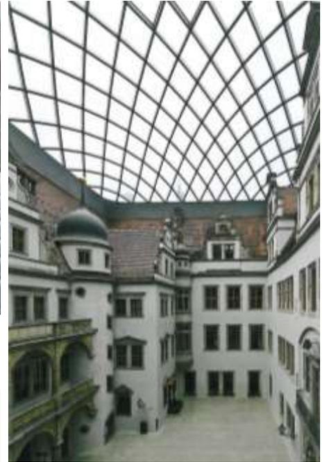
Durch die leichte ETFE-Kisseneindeckung müssen deutlich geringere Lasten in den Bestand eingetragen werden als bei einer herkömmlichen Glaseindeckung.
