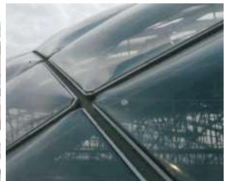
Die Eindeckung der Kuppel erfolgte mit 265 pneumatischen Kissen, die die ca. 615 m<sup>2</sup> Grundfläche des kleinen Schlosshofs überdecken.
