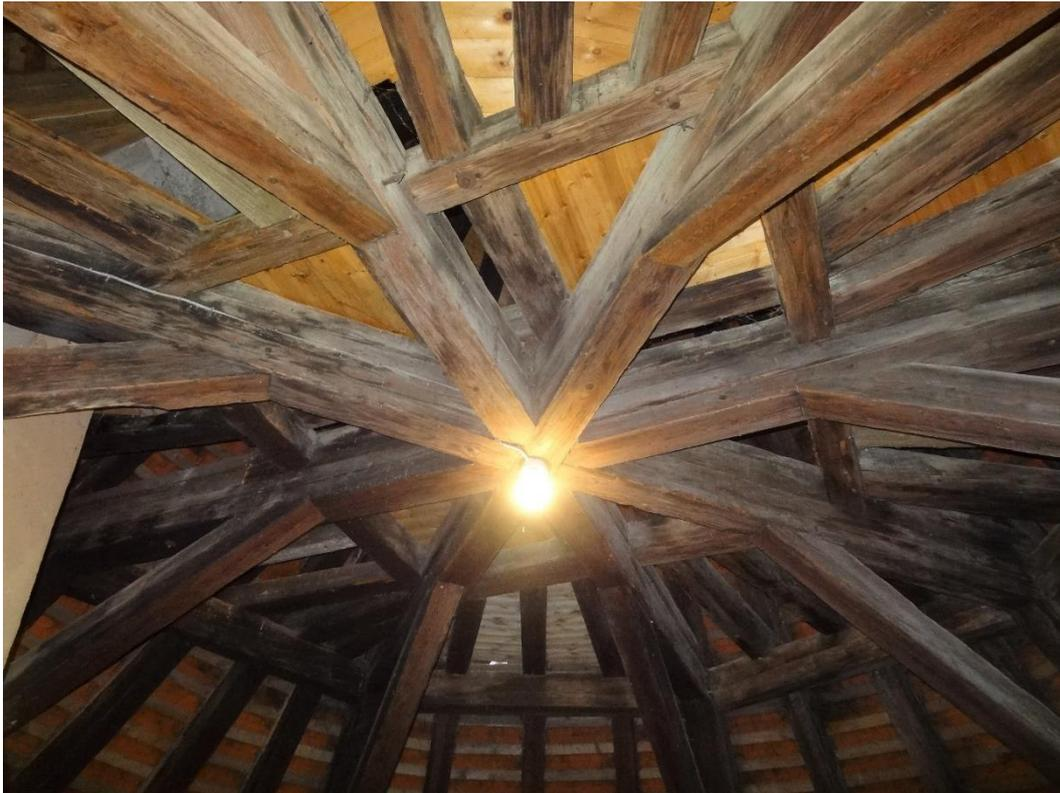
**Bild 9** Turmdach, 1. Dachgeschoss, Kehlbalkenebene als Sternbalkenlage konstruiert
