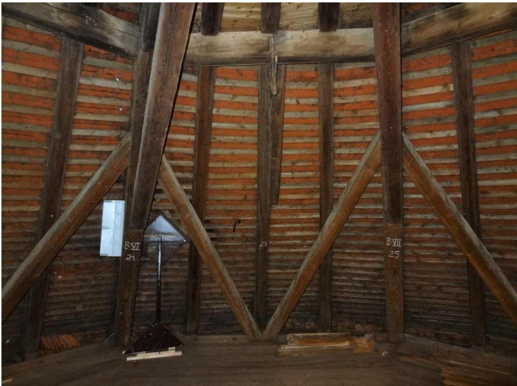
**Bild 8** Turmdach, 1. Dachgeschoss, liegende Bundkonstruktionen mit Fünfkant-Stuhlschwelle, Stuhlrähm und Windverbandsstreben
